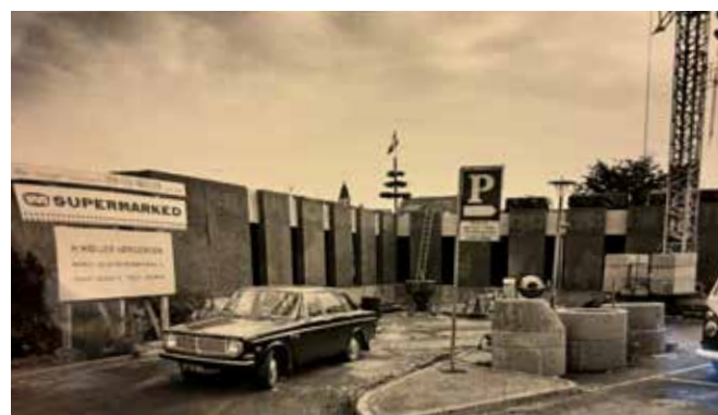
Rejsegilde på det nye Vivo Supermarked i Mellemgade
